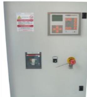
Centralina RGK800 con multimetro (voltmetro, amperometro frequenzimetro, contaore e voltmetro batteria). Caricabatteria, funzione test periodico e riferimenti di rete. Moduli di espansione EXP ed ingresso analogico programmabile.
