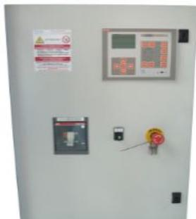
Centralina RGK800 SA con multimetro (voltmetro, amperometro, frequenzimetro, contaore e voltmetro batteria).
