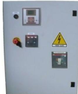
Centralina RGK600 con multmetro (voltmetro, amperometro, frequenzimetro, contaore e voltmetro batteria). Caricabatteria, funzione test periodico e riferimenti di rete.
