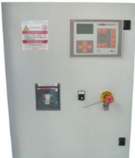
Centralina RGK800 SA con multimetro (voltmetro, amperometro, frequenzimetro, contaore e voltmetro batteria).
